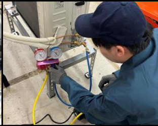
④ 電気工事士のお仕事 エアコンの取付、電気の配線に挑戦しよう！
